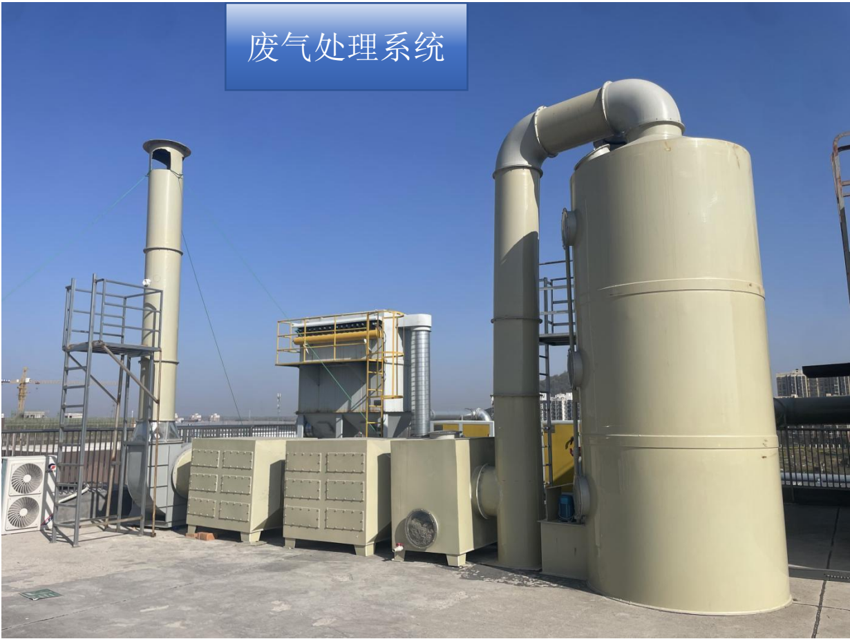
图 3.2-2 废气收集/处理设施
