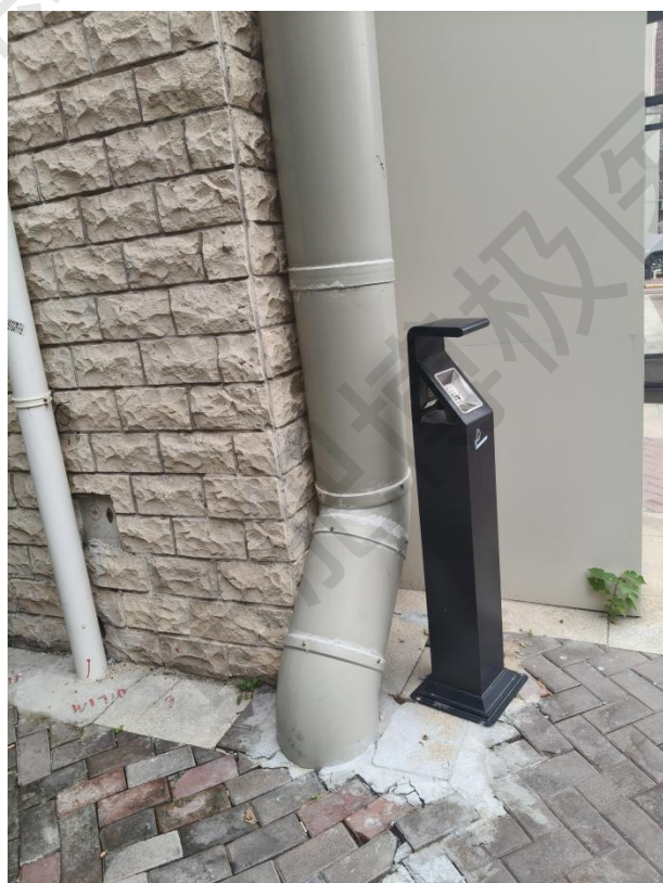
污水处理设施废气收集管道
