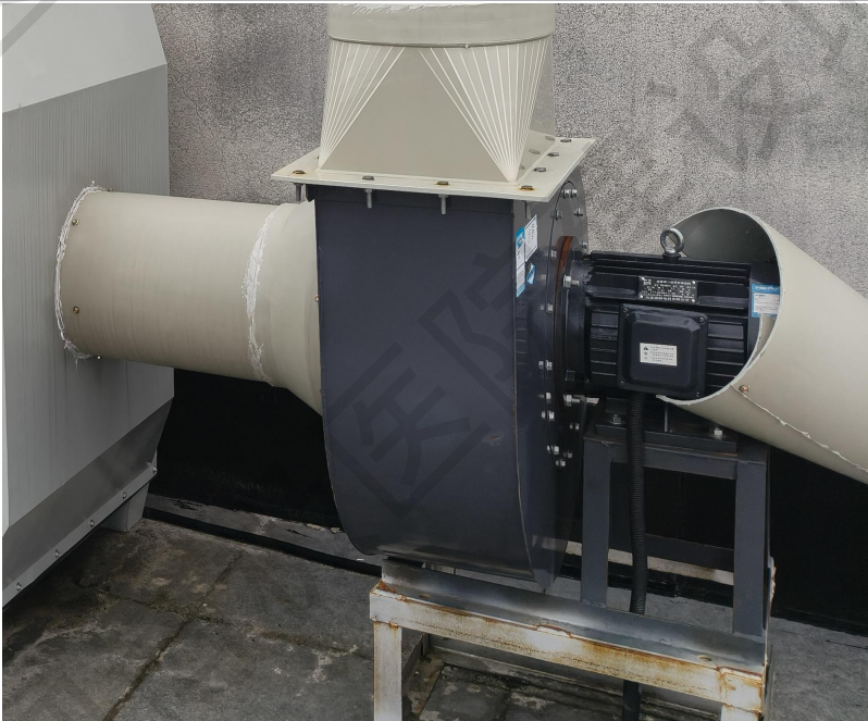
图 4-4 废气处理设施风机减震
